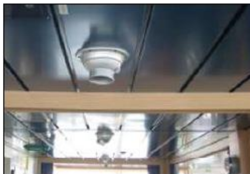
Εικόνα 35 Διαχύτης τύπου punkah (*)
