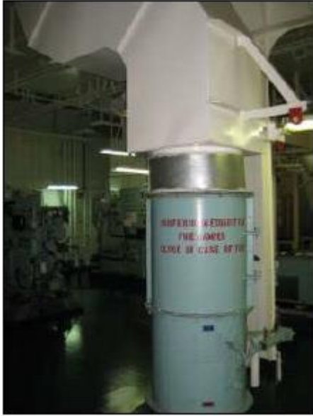
Εικόνα 44 Διάταξη Ανεμιστήρας με αγωγό κυκλοφορίας του αέρα.
