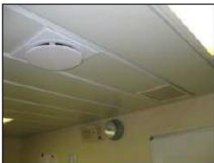
Εικόνα 34 Θολωτός διαχύτης αέρα
