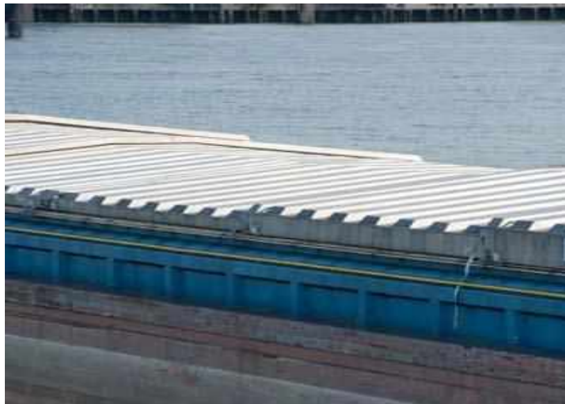
Εικόνα 24. Επαρκώς συντηρημένα hatch covers φορτηγού πλοίου (Πηγή: https://www.standard-club.com/media/58123/MGHatchCoverMaintenance.pdf )
