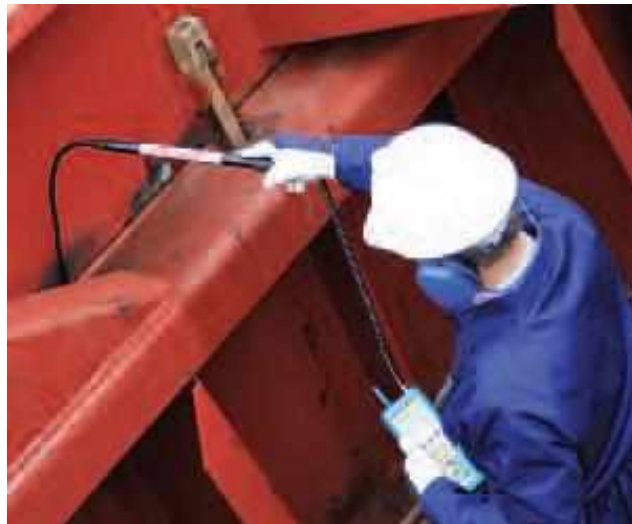
Εικόνα 35. Ultrasonic leak detection test - Λήψη μετρήσεων αισθητήρα (Πηγή: https://maritimecyprus.files.wordpress.com/2017/09/risk_focus_-_hatch_covers.pdf )
