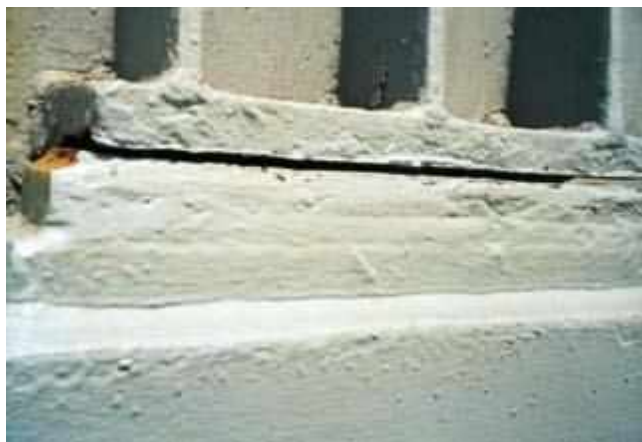
Εικόνα 28. Φθορές σε steel-to-steel επαφές των hatch covers με τα hatch gaskets (Πηγή: https://www.standard-club.com/media/58123/MGHatchCoverMaintenance.pdf )
