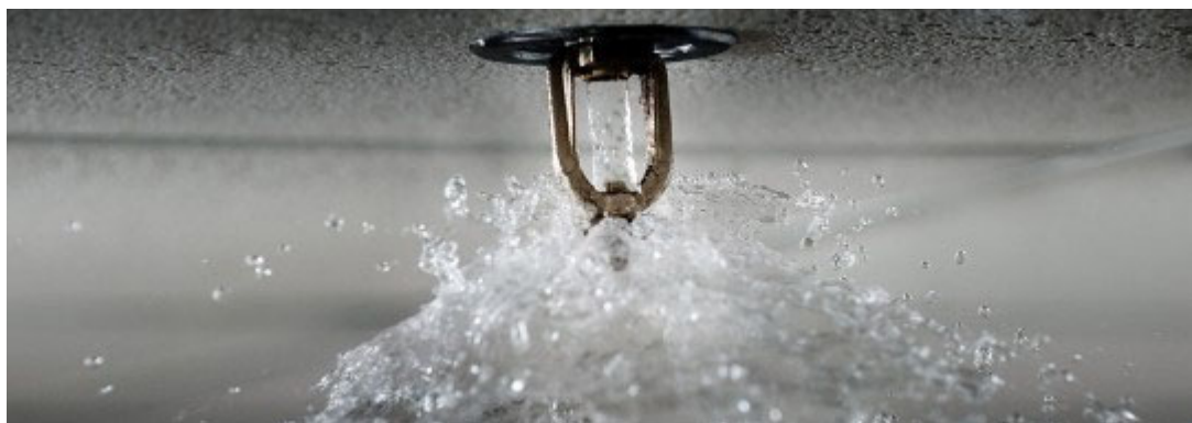
Εικόνα 3. Ανιχνευτής συστήματος Sprinkler ( http://users.sch.gr/jabatzo )
