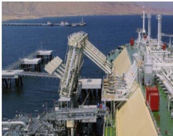
Βραχίονες φορτοεκφόρτωσης συνδεδεμένοι με τις πολλαπλές του πλοίου
