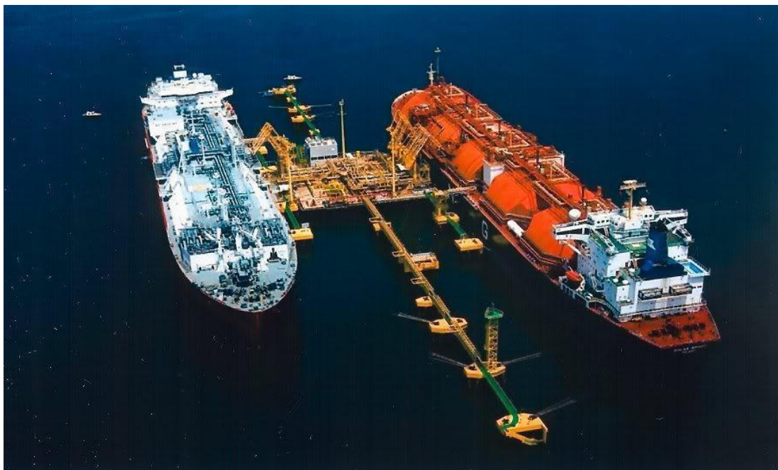
Η πλωτή εγκατάσταση επαναεριοποίησης Egat, στο κράτος της Αιγύπτου
