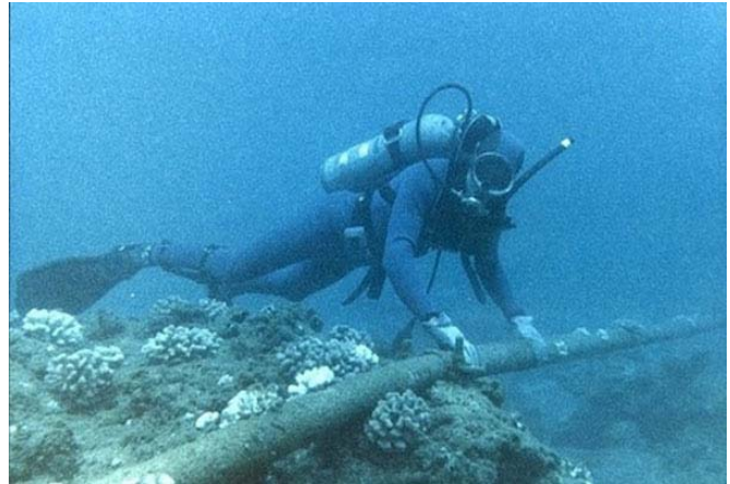
Εικόνα 4.6.1.4 δύτες που οδηγεί το καλώδιο στον βυθό
