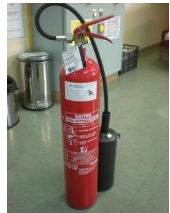
CO2 Fire Extinguisher
