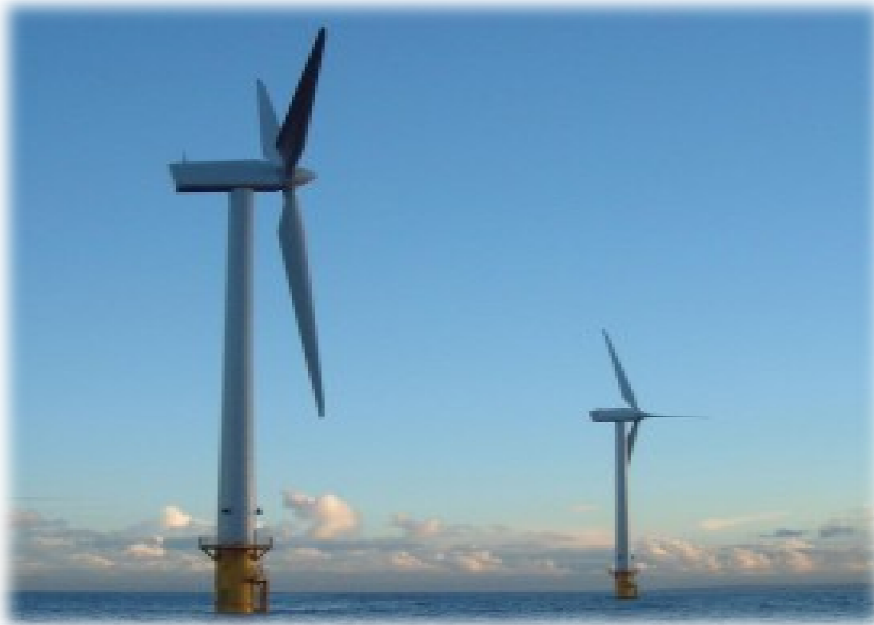
Εικόνα 19: Ανεμογεννήτρια οριζοντίου άξονα
