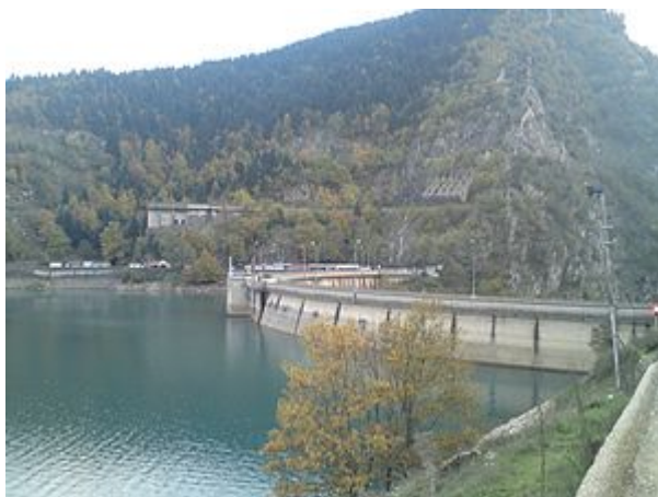
Εικόνα 7: Υδροηλεκτρικό φράγμα στη λίμνη Πλαστήρα
