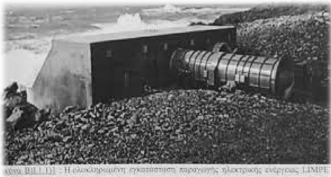
Εικόνα 21: Μηχανισμός ταλαντούμενης στήλης
