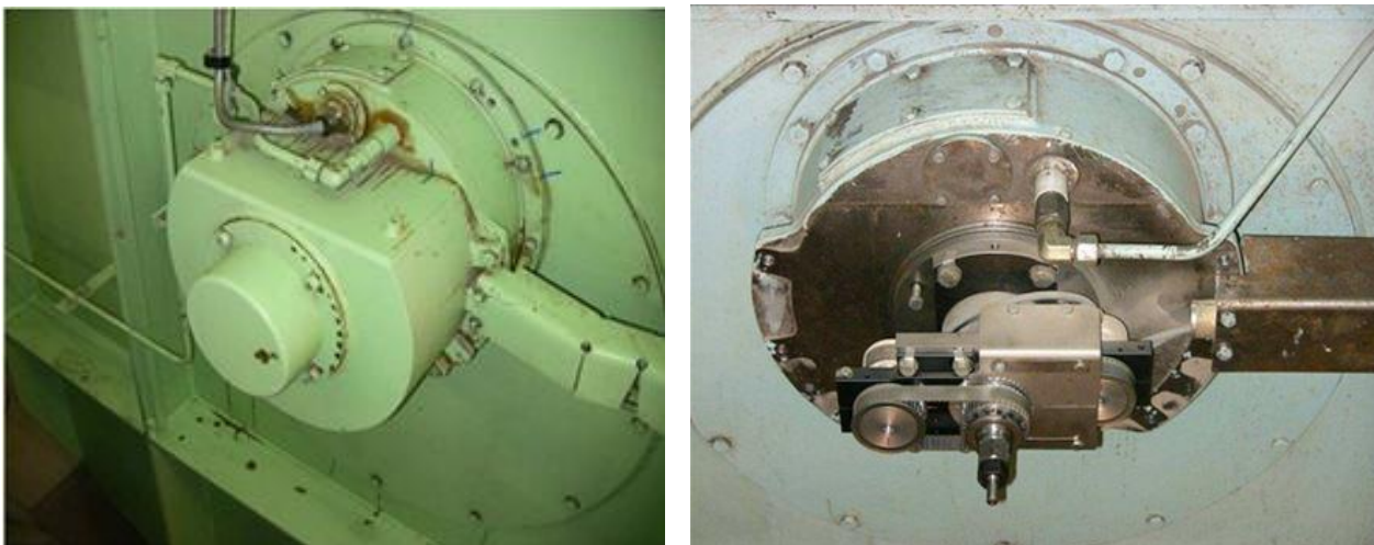
Εικόνες 5-6: Αισθητήρας γωνίας στροφάλου (Crank Angle sensor).
