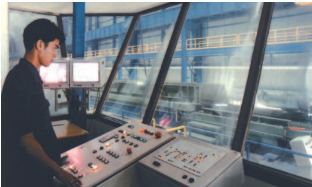
Σχήμα 3.10: Τράπεζα χειρισμών εγκατάστασης αυτοματισμού.
