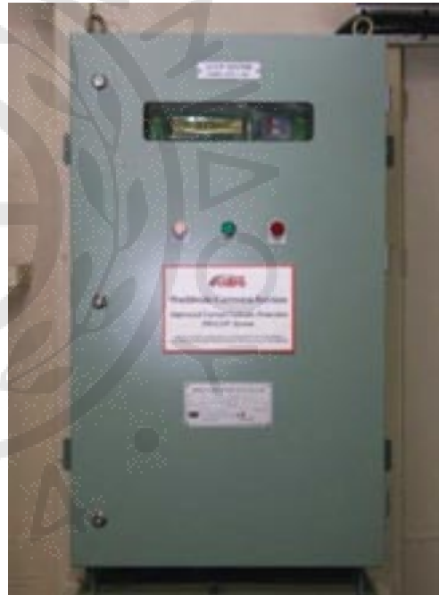
Σχ. Π.Β.13γ Μονάδα επιβολής ρεύματος – Εξωτερική διάταξη.
