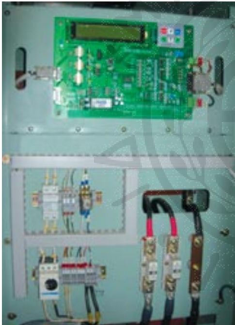
Σχ. Π.Β.13β Μονάδα επιβολής ρεύματος – Εσωτερική διάταξη.
